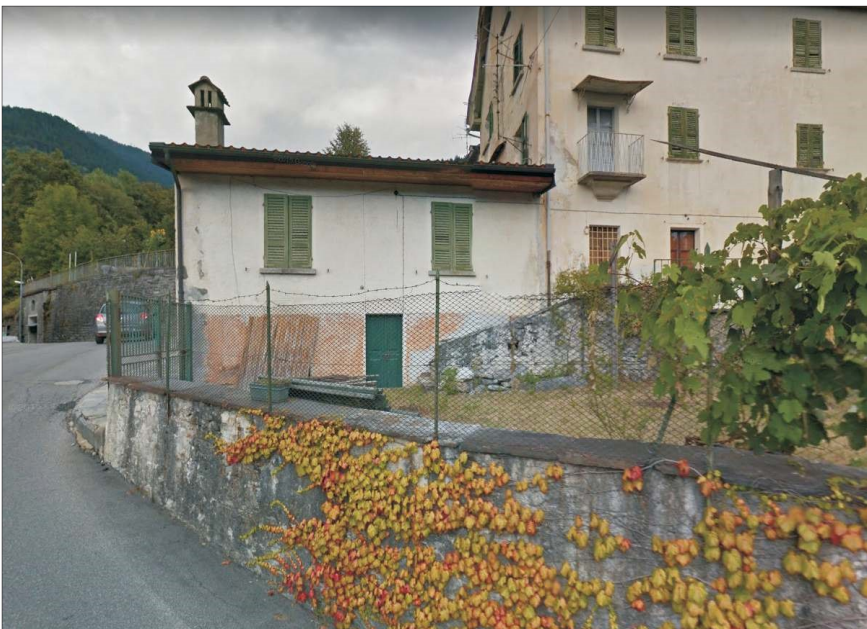
FOTO n. 3: vista frontale del muro in fregio a via I Novembre da demolire e del retrostante corpo di fabbrica che verrà sopraelevato.
