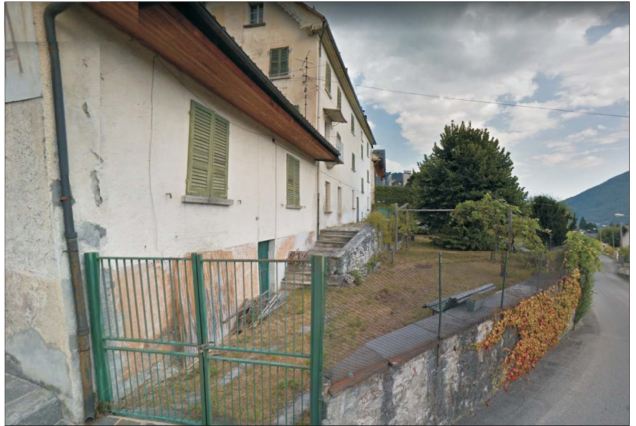
FOTO n. 2: vista laterale (da ovest) dell'edificio oggetto del piano di recupero; il muretto in fregio a via I Novembre verrà demolito, in modo da procedere alla formazione dell'ingresso carrabile al garage che verrà ricavato al piano seminterrato.
