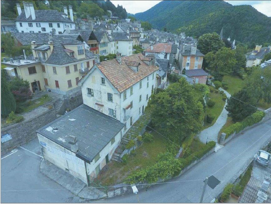
FOTO n. 1: panoramica dell'edificio ex "Albergo Bellavista" e dell'area a giardino pertinenziale antistante (immagine estrapolata dalla documentazione fotografica di progetto); si apprezza, in primo piano, il corpo di fabbrica occidentale che verrà sopraelevato, dotandolo di una copertura a due falde (tetto in "piode").
