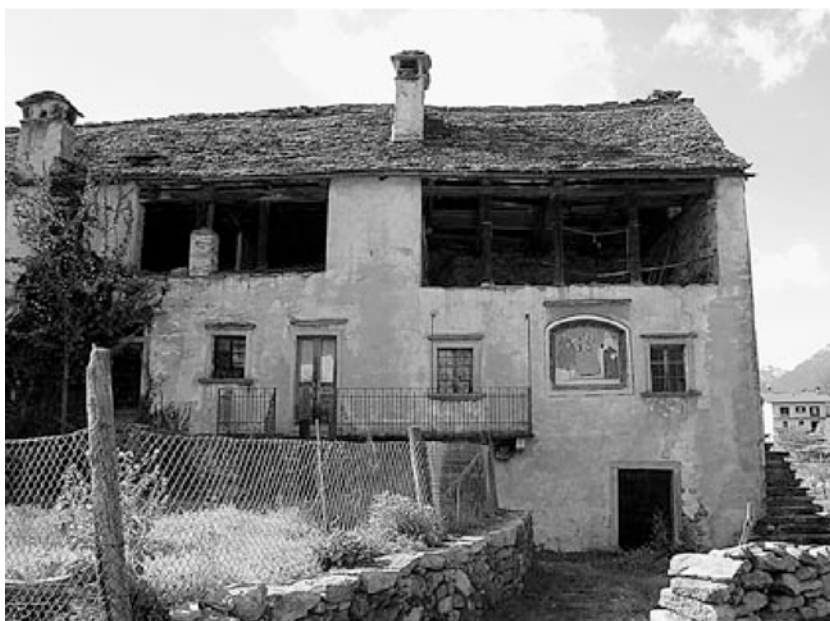
Edificio a Montecrestese con facciata decorata e sovrastato dall' astic , luogo ove venivano disposte le granaglie per la conservazione
