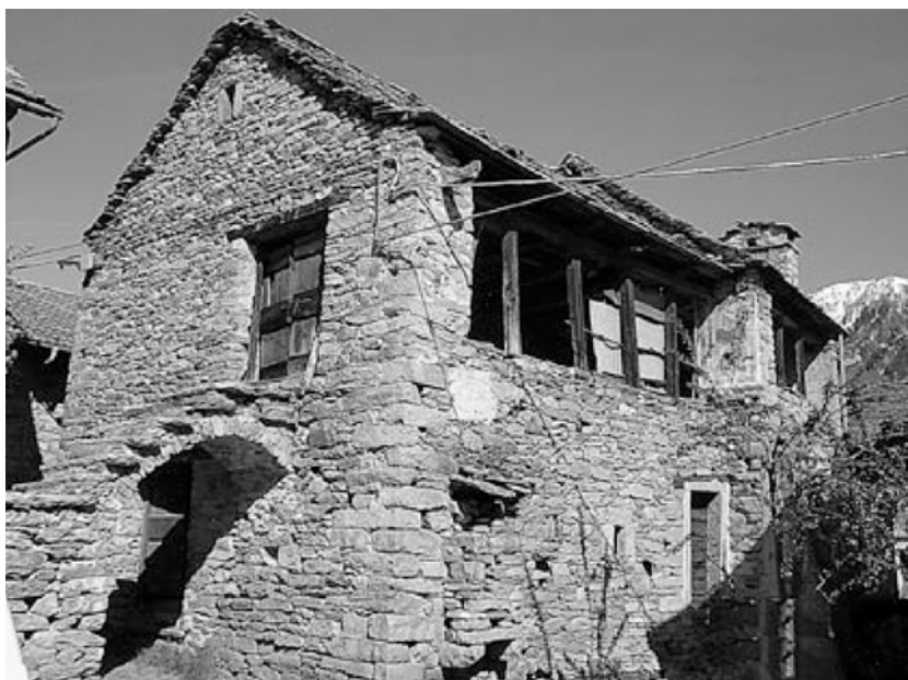
L'edificio a Montecrestese mostra le ridotte sporgenze della copertura a protezione dell' astic , la pietra sagomata per reggere il canale di gronda, e le scale rampanti.
